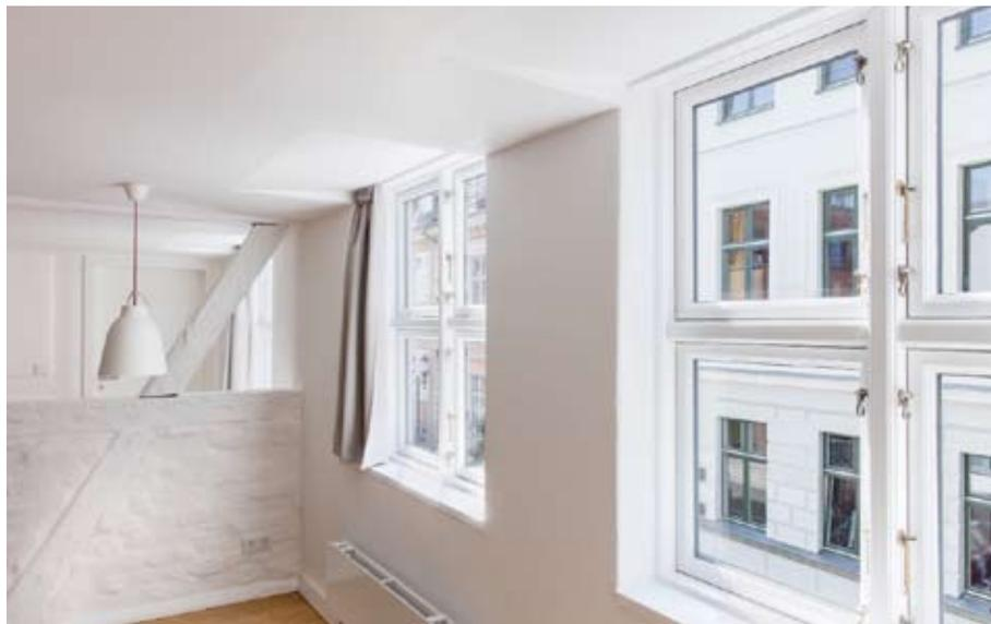
Im Obergeschoss variieren die Sturzhöhen über den dänischen Sprossenfenstern, deren Flügel sich nach außen öffnen. | Foto: Dr. Cordia Schlegelmilch
